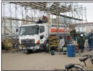
屋外タンクから移動タンク貯蔵所に 危険物を移し替えている様子
